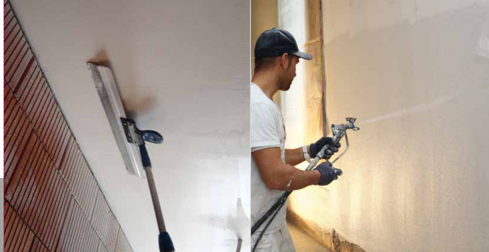
Stropno nanošenje glet mase
