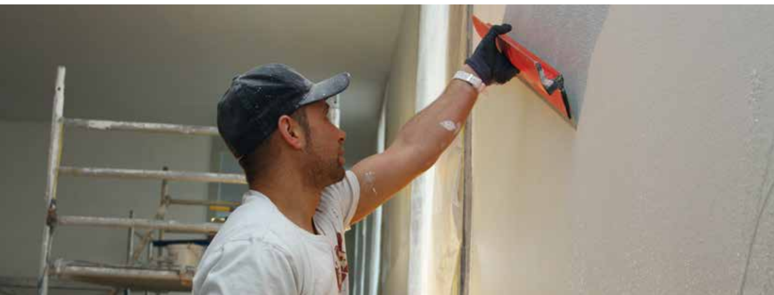
Ručno nanošenje glet mase
