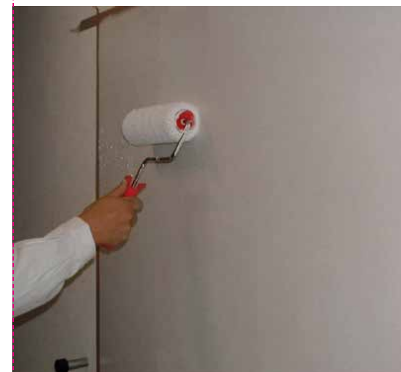
Nanošenje predpremaza
